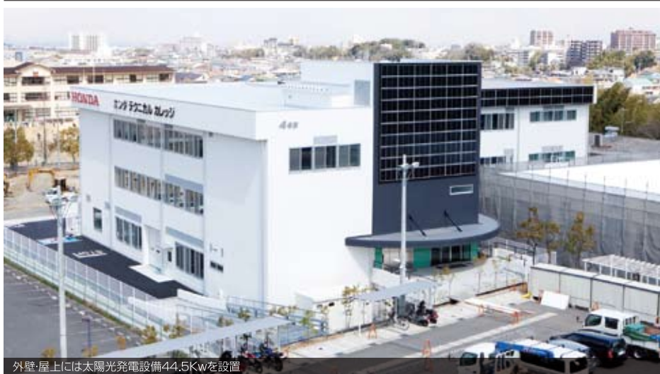
外壁・屋上には太陽光発電設備44.5Kwを設置
